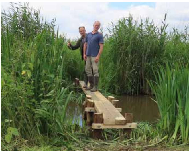
Rob en Cor, de trotse bouwers van de nieuwe brug
